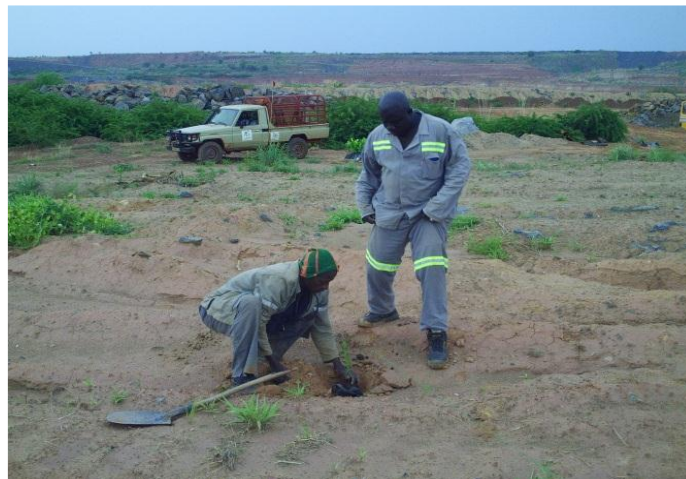
Figure n°9 : Mise en terre de plants sur les roches recouvertes de terre végétale
