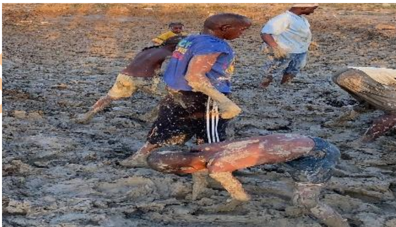
Photo n°02 : Image du Matériau BATAKARA prise lors du mélange
